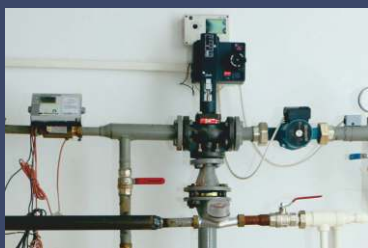
Трехходовые клапаны Danfoss и Regin
